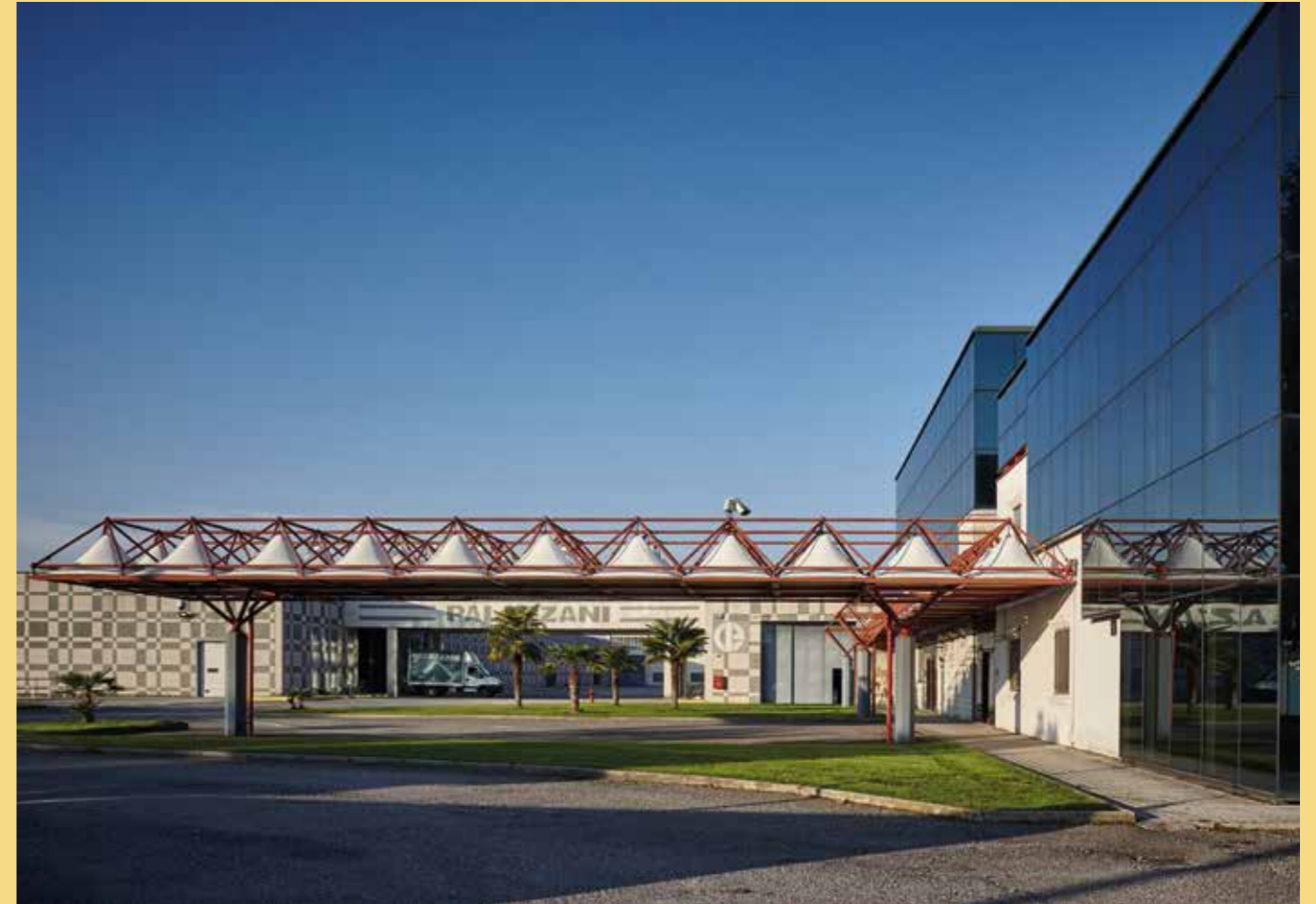
Sede della produzione e magazzino di Casalmorano, Cremona Production headquarters and warehouse in Casalmorano, Cremona
